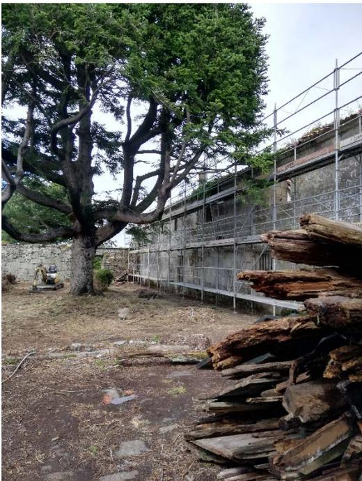
Se procede a la implantación en obra del andamiaje que servirá como acceso y protección para la realización de los trabajos en las fachadas y cubierta del pazo.
